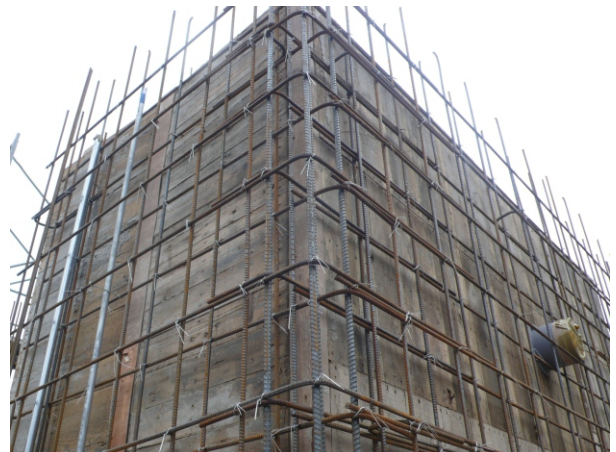
依結構標準圖說施作之牆轉角鋼筋。
