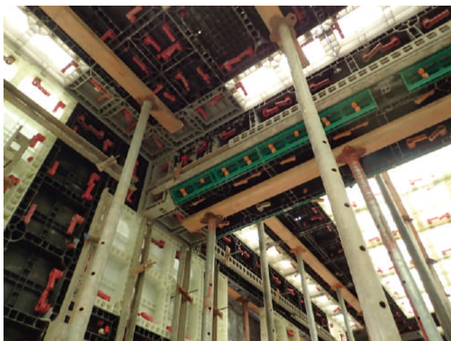
●「Alfa Safe系統模板工法」緊結器採用三節式蓮霧頭螺桿，孔位置都是事先規劃，提升施工品質。
