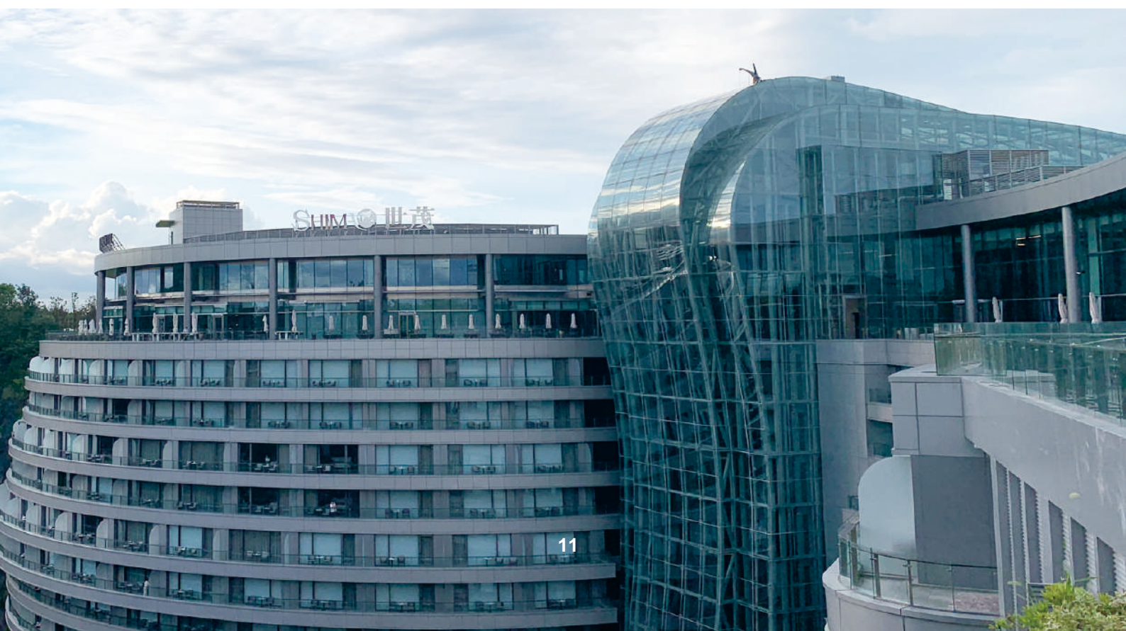
深坑酒店由平面向下的驚人建築工程
