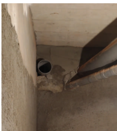
■ 改善方式：管道間接管處完整填實，使用矽利康進行密封，以避免廢氣進入。
