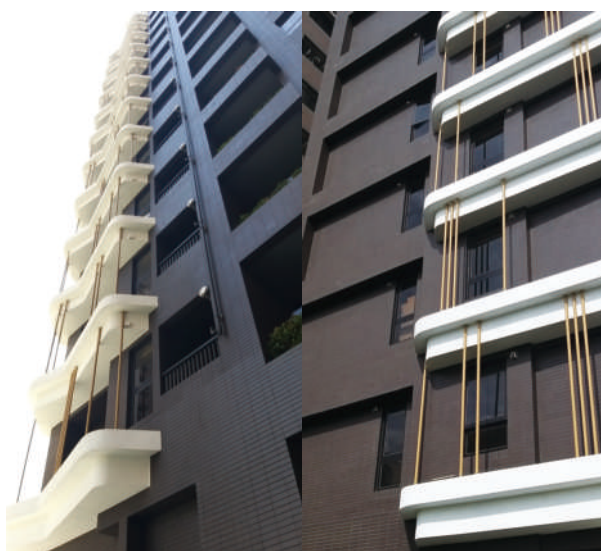
■ 當層排氣大樓戶外排氣孔（圖由中麗建設-中麗璞聚提供）。
