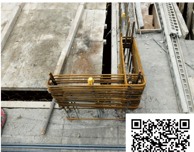
● 結構安全系統工法-牆箍系統工法影片介紹。
