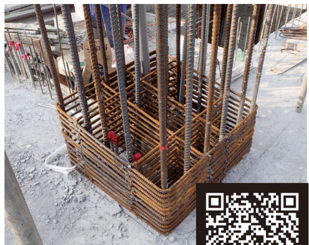
● 結構安全系統工法-柱箍系統工法影片介紹。
