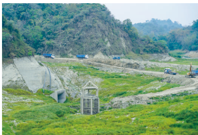
■終年零水量的白河水庫正在進行清淤作業。
