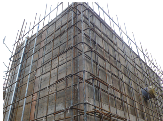
●依結構標準圖說施作之牆轉角鋼筋。
