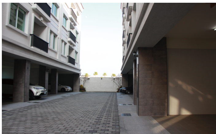
▲一樓可併排三輛車的大空間
